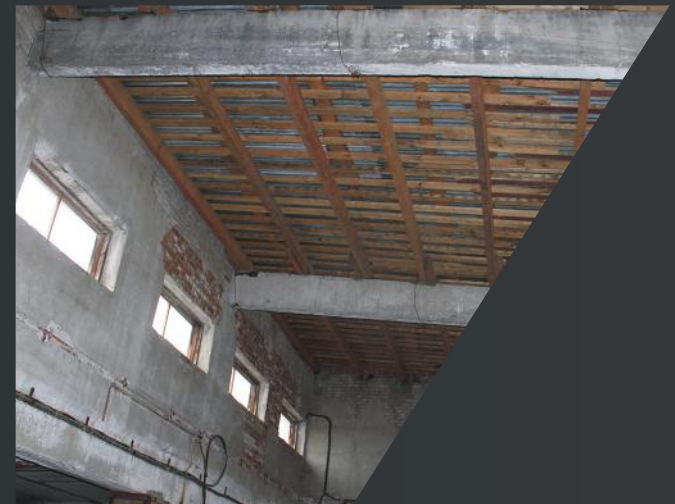
Обследование технического состояния строительных конструкций производственного здания
