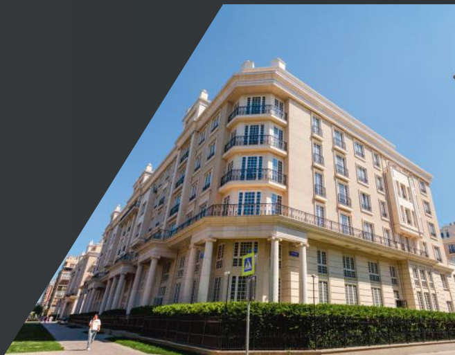
Обследование конструкций колледжа жилого комплекса «Найтбридж»
