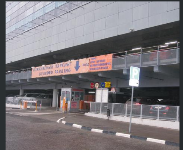
Обследование конструкций паркинга терминала Аэроэкспресс
