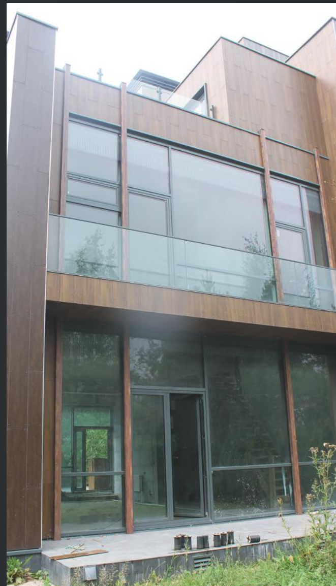
Обследование конструкций зданий коттеджного поселка Футуро-Парк
