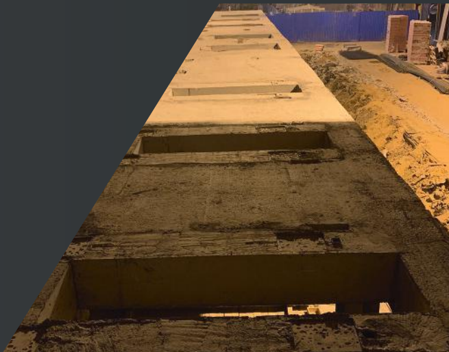
Обследование конструкций типографии
