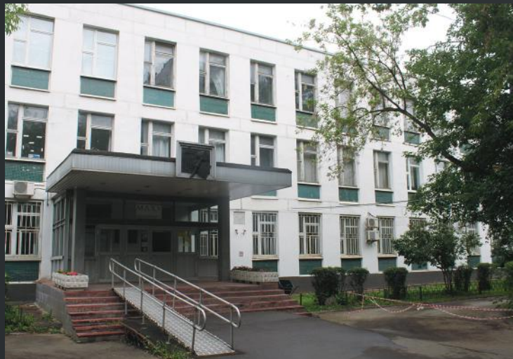
Обследование конструкций Художественного колледжа
