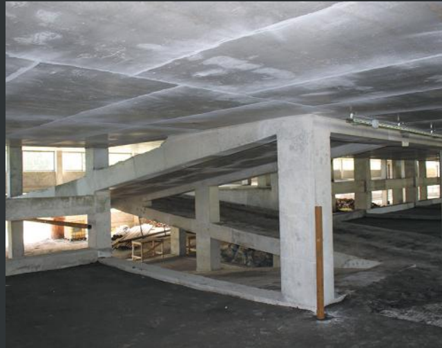
Обследование конструкций шестиэтажной автостоянки
