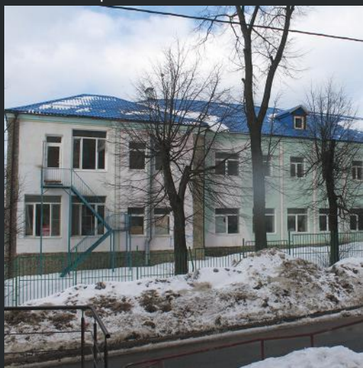
Обследование конструкций детского сада
