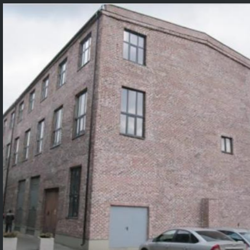
Обследование строительных конструкций офисного здания
