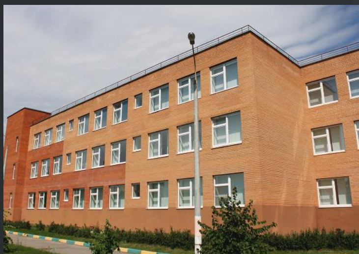
Обследование конструкций школы
