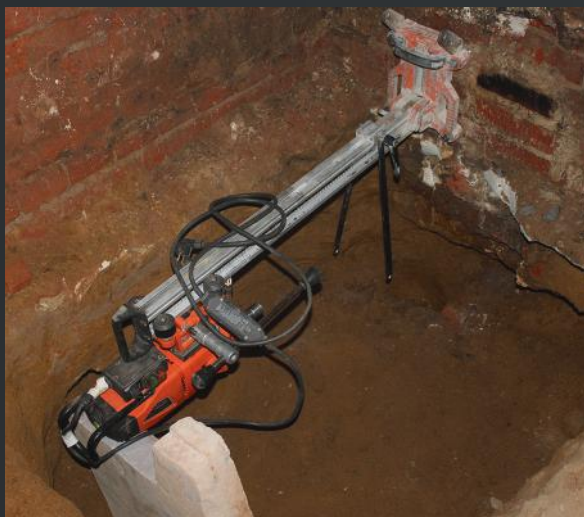
Обследование фундаментов офисного здания, г. Москва
