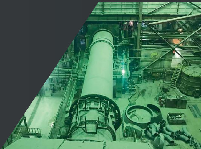
Обследование технического состояния строительных конструкций, АНОФ-2 КФ АО «Апатит»
