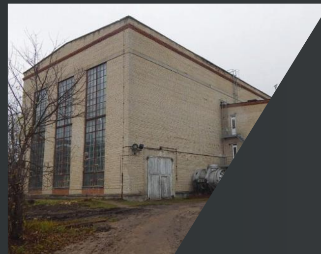
Обследование строительных конструкций здания компрессорной станции воздуха высокого давления
