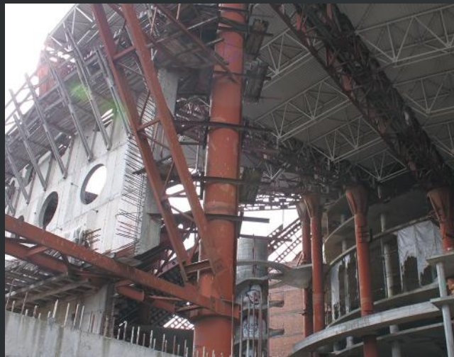
Обследование технического состояния Аквапарка
