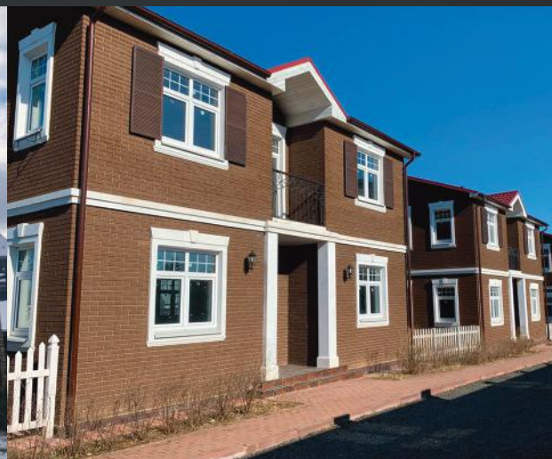
Обследование строительных конструкций жилых домов
