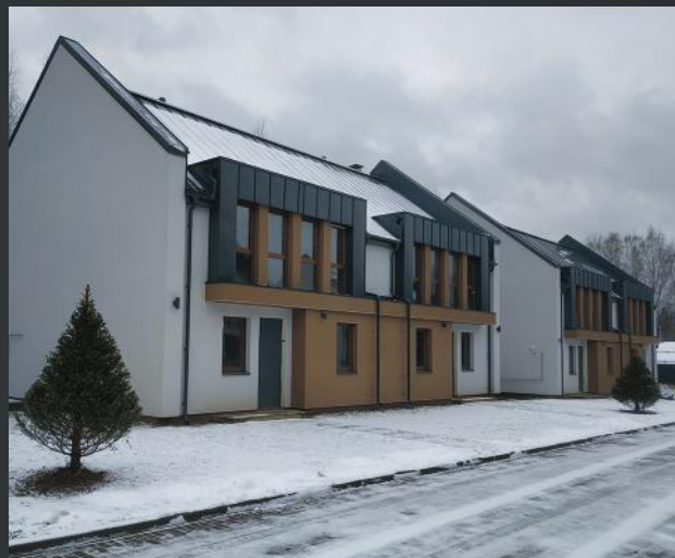
Обследование конструкций таунхаусов
