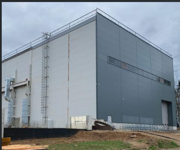
Обследование корпуса производства емкостей теплообменников
